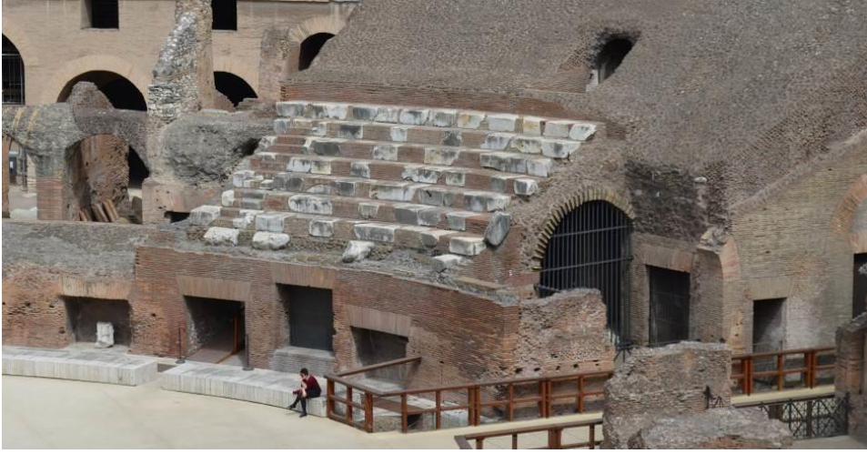
Şekil 2. Collesium’da taş olan oturma sıralarının tuğla örgü ile bütünlenmesi (Kafa Duran, E. Kişisel arşiv, 2016).
