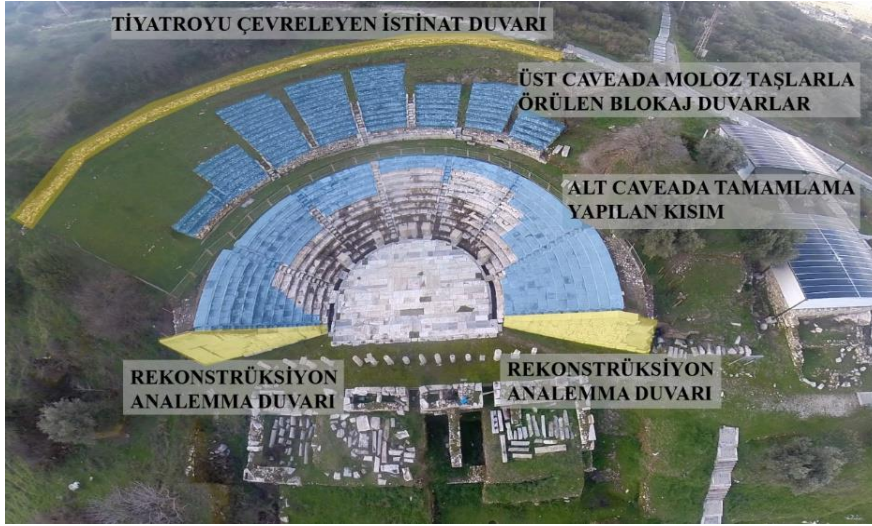
Şekil 12. Metropolis Tiyatro yapısı restore edilen kısımları (Metropolis kazı arşivi, 2015)
