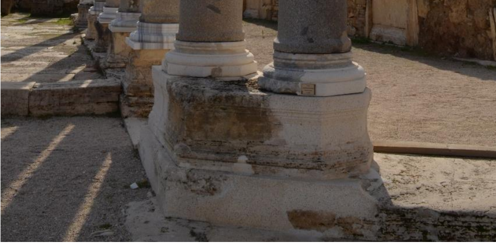
Şekil 5. Perge Antik Kenti Batı Cadde’de agrega ve kireç kullanılarak hazırlanan harç ile yapılmış bütünleme (Kafa Duran, E. Kişisel arşiv, 2017)
