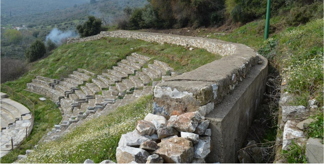
Şekil 18. Üst cavea oturma sıralarının bütünlenmesi ve drenaj kanalı (Kafa Duran, E. Kişisel arşiv, 2017)
