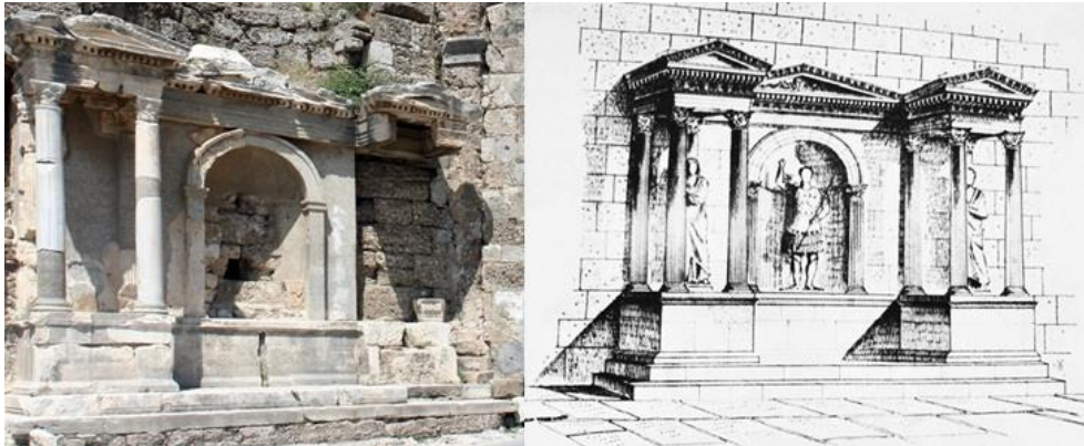
Şekil 4. Side Vespasian Anıtı çimento harçlı onarım sonrası durumu ve restitüsyonu (Side Vespasian Anıtı, b.t.)
