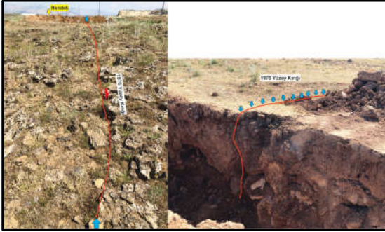
Şekil 11. 6 No'lu fay kolunda 1976 depreminden kalma yüzey kırığı ve Hendek-5'deki uzanımı (bakış D ve GB'ya)
