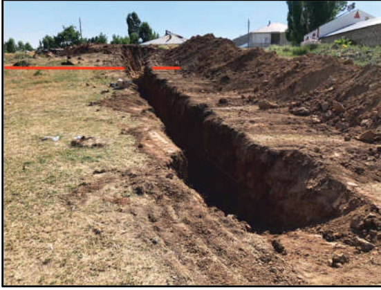
Şekil 20. Hendek-2'nin görünümü (bakış G'e)
