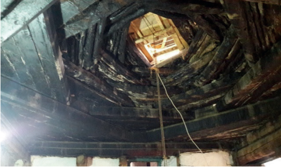
Resim 18: Tandır evinin kırılmalı tavan yapısı (Fotoğraf; Arif Çoruh).
