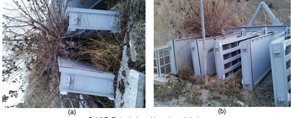
Şekil 7. Batardo kapaklarından görünüm
