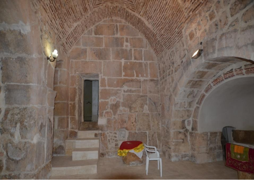
Fotođraf 6: Meryem Ana Kilisesi, iç mekandan bir görünüm.
