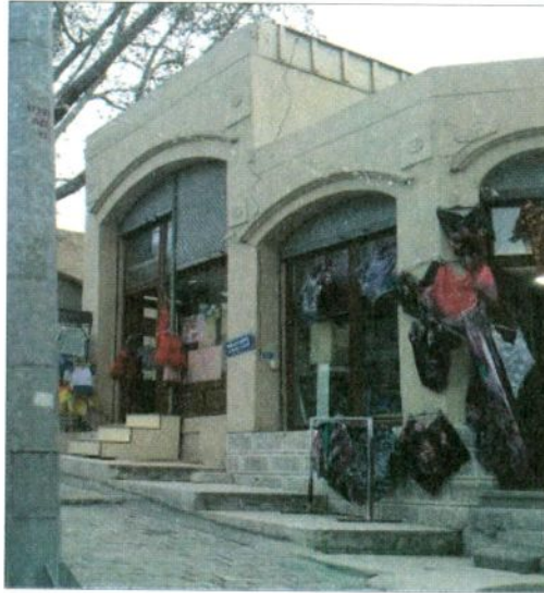
Resim 3. Eğime Dik Olarak Gelişen Yapı Yerleşim Şekli, 2013.
