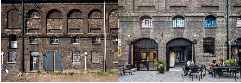
Şekil 7. Doğu kömür deposunu batı cephesinde yenileme öncesi ve sonrası ( https://www.flickr.com/photos/mattkieffer/ ), ( https://iyouall.com )
