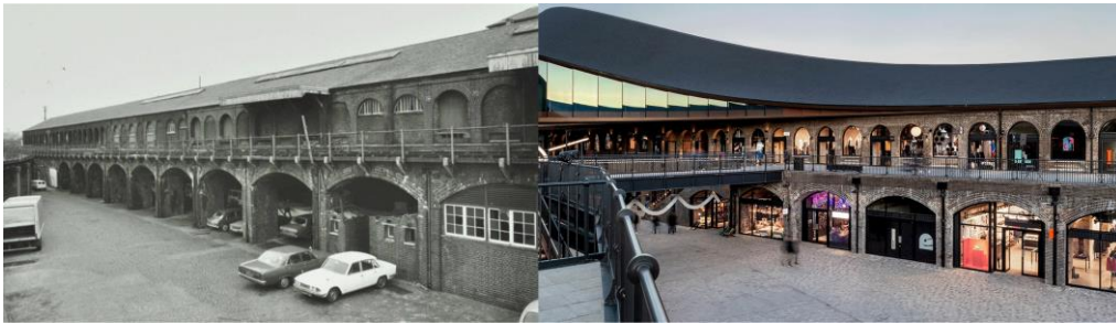
Şekil 6. Yenileme çalışmaları öncesi ve sonrası doğu kömür deposu ( https://www.ft.com ), ( https://medium.com )
