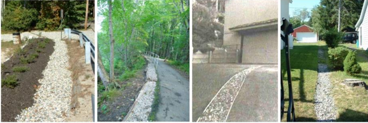
Şekil 7. İnfiltrasyon hendeği örnekleri (AWWA, 2019).
