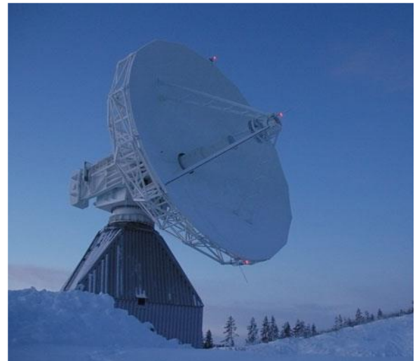
Şekil 6. TTCF S-Band 11m boyutunda çanak anten
