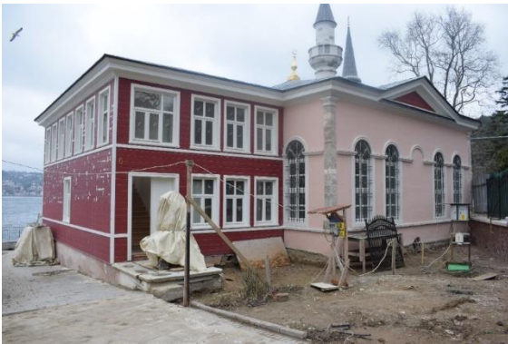
Fotoğraf 2: Mescid ve Hünkâr Kasrı (Güney Cephe)
