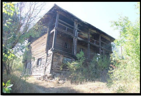
Fotoğraf-2: Güneydoğu'dan Genel Görünüş
