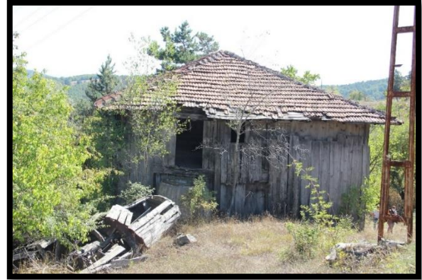
Fotoğraf-6: Kuzey Cephe
