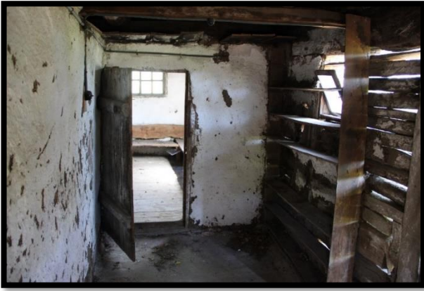
Fotoğraf-10: Zemin Kat Giriş Mekanının Doğusu
