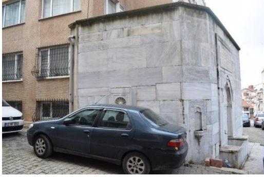
Fotoğraf 27: Kaptan Paşa Çeşmesi Güney Cephe
