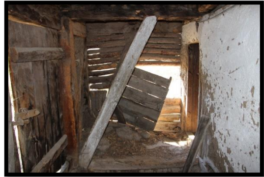
Fotoğraf-8: Zemin Kat Giriş Mekânının Batısı
