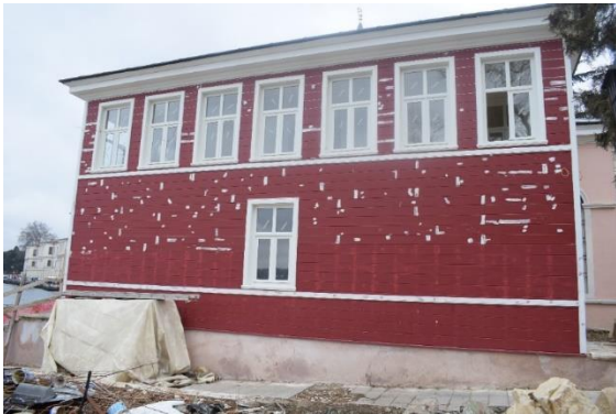
Fotoğraf 3: Hünkâr Kasrı Batı Cephe
