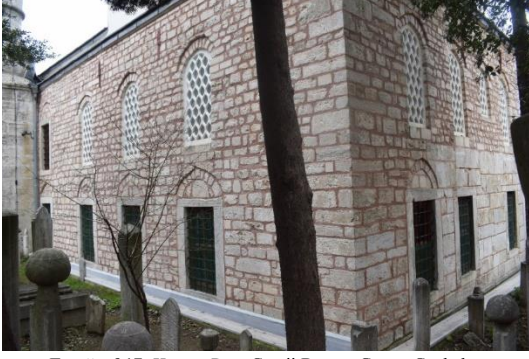
Fotoğraf 17: Kaptan Paşa Camii Batı ve Güney Cepheler
