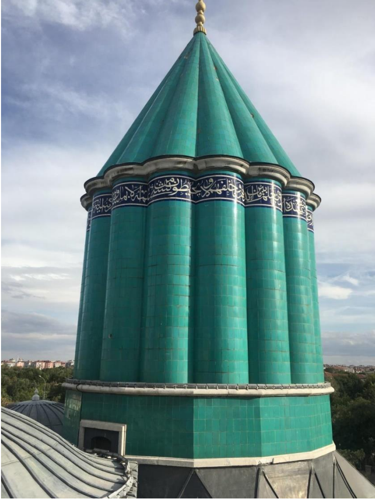
Fotoğraf 1: Mevlâna'nın Türbesi (Karamanođlu döneminde yaptırılmış olan dilimli gövde ve külahın 1964 yılında deđiştirilmiş olan günümüzdeki çinileri)
