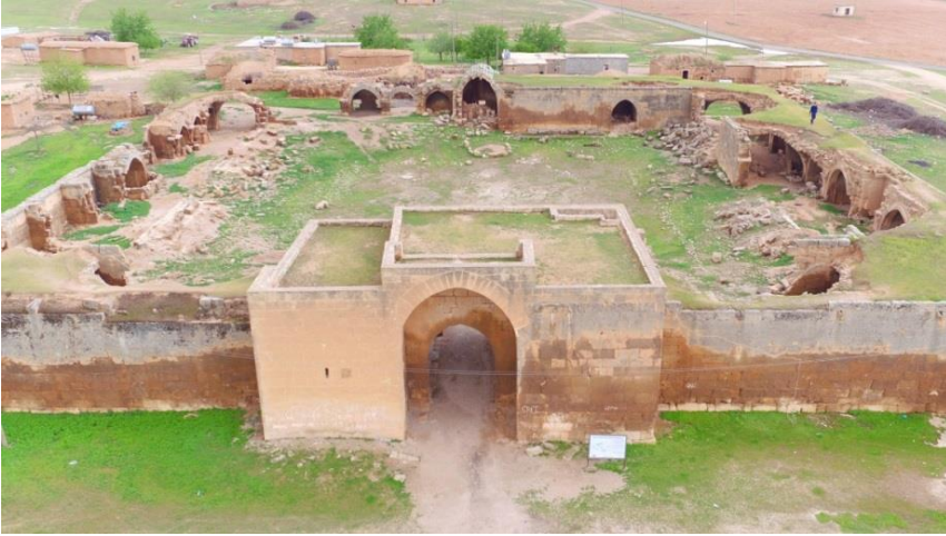
Şekil 5. Kuzey Cephesi ve Avlu (Y. Küçük, 2017)
