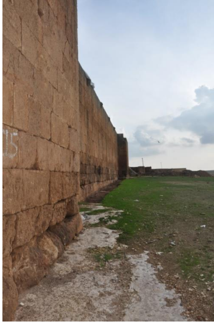
Şekil 56. Batı Cephesi Zemin Kazısı Ve Ana Kaya
