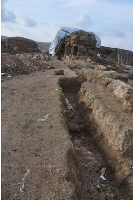
Şekil 55. Güney Cephesi, Zemin Kazısı
