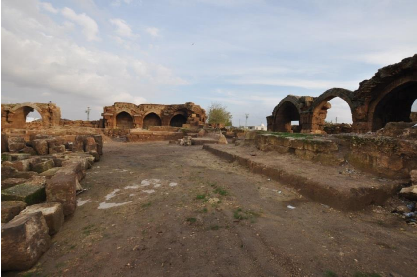
Şekil 20. Avlu – Güney Ve Doğu Tarafı, Kazı Ve Temizlik Çalışmaları Sonrası
