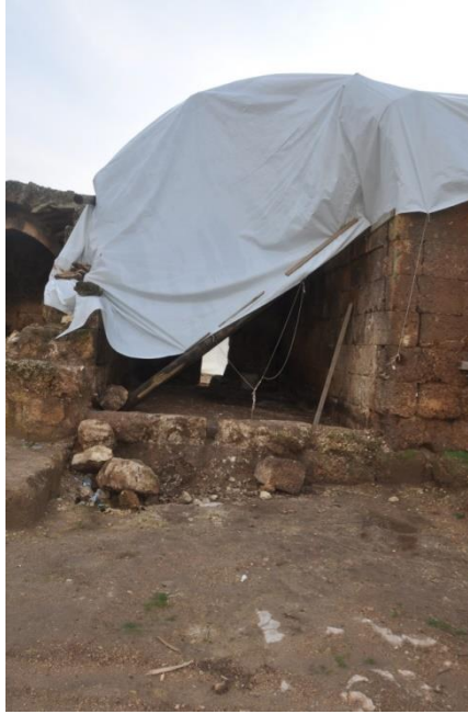
Şekil 50. Ana Eyvan, Kazı Ve Temizlik Çalışmaları Sonrası
