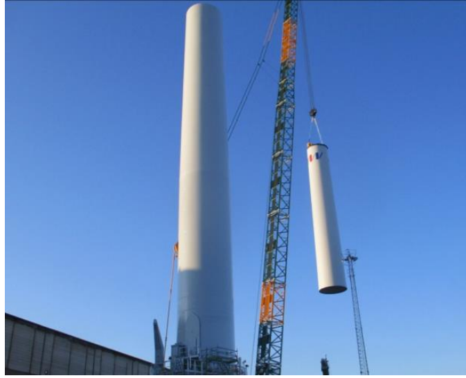
Şekil 9. Kule Montajı.
