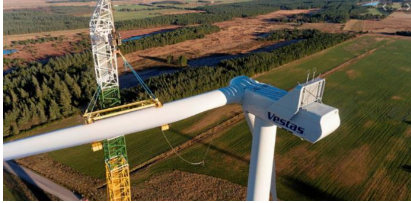
Şekil 10. Kanat Montajı.
