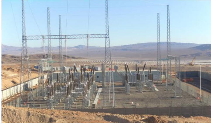
Şekil 6. Şalt Binasının Yapımı.
