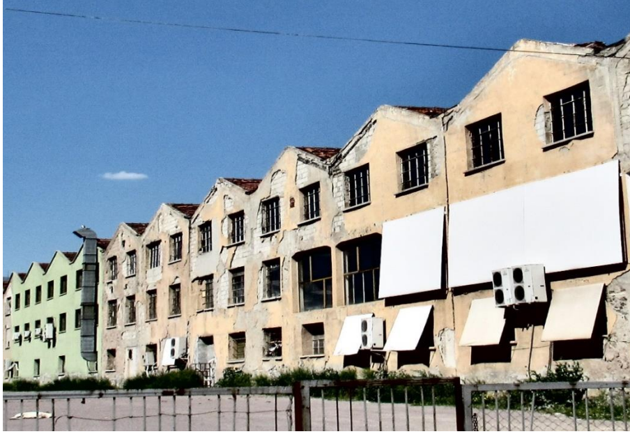
Foto 1. On dokuzuncu yüzyılda kurulan depo ve üretim tesisleri ile başlayan Liman Arkası Bölgesi İzmir'in ilk sanayi bölgesi olarak kurulmuş, yakın zamana kadar işlevini sürdürmüştür. Günümüzde bu alanda on dokuzuncu yüzyıl sonu ve yirminci yüzyıl başına ait büyük ölçekli sanayi tesisleri halen ayaktadır.
