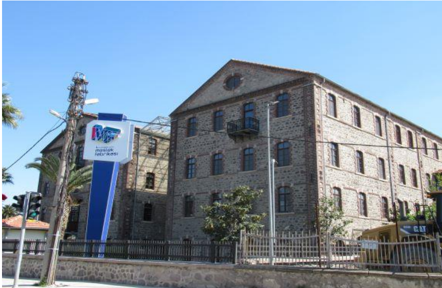
Foto 3. Halkapınar'da bulunan eski tarihi un fabrikası bugün, Fabrikasyon Laboratuvarı (FabLab) yani kişisel fabrika ortamı sağlayan küçük ölçekli ve insanların özgürce üretim yaptıkları yaratıcılık atölyelerine dönüştürülmüştür.
