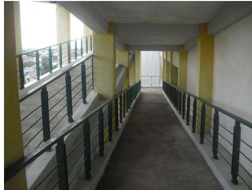
Şekil 13. TDMRC Kaçış (Tahliye) Binası
