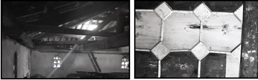
Şekil 6. Tavan yenilenmesi (VGM, 2019)
