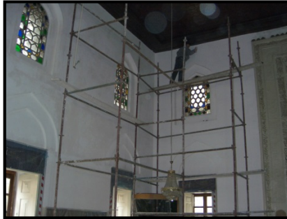
Şekil 19. Onarımda alçı uygulaması (VGM, 2019)
