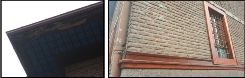
Şekil 15. Ahşap bozulmaları
