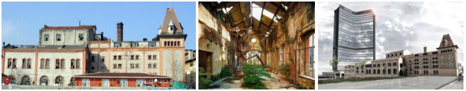
Şekil 11. Bomonti Bira Fabrikası'nda üretim faaliyetlerinin durması, fabrikanın metruk hale gelmesi ve restorasyon sonrası yenilenen yüzü (Şişli Belediyesi)
