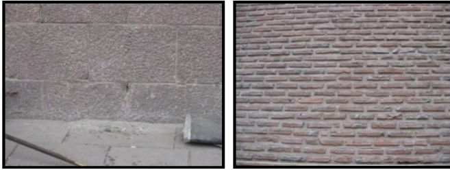
Şekil 11. Derz aralarında harç kullanımları
