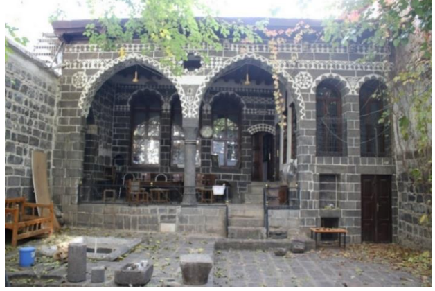
Foto 5: Eyvan Türleri (Dabanoğlu Mah. 175 ada 5 parsel)
