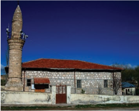
Fotoğraf 10: Batı cephe
