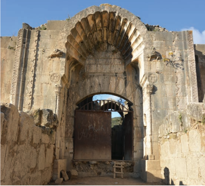
Fot. 18: Kazı çalışmaları sonrası taçkapı.
