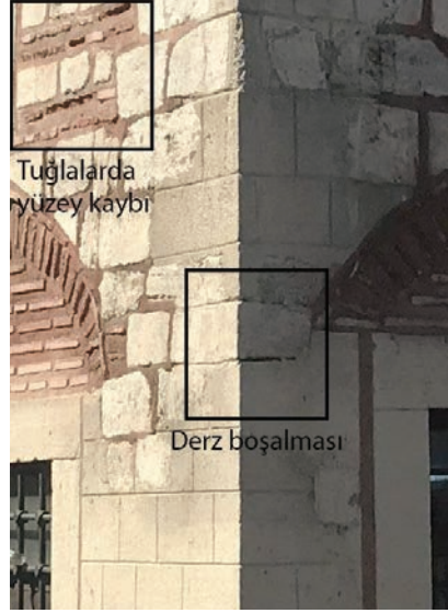
Görsel 20. Nur-u Osmaniye Camisi'ne bakan güney ve doğu cephelerinin kesişim noktasında görülen derz boşalması ve güney cephesindeki tuğlalarda yüzey kaybı.
