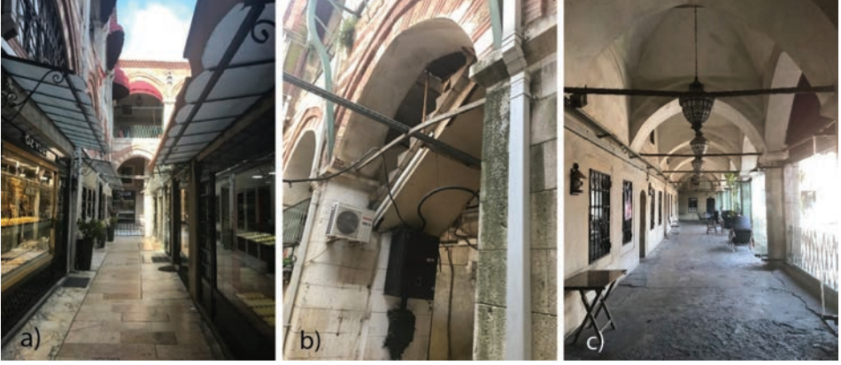
Görsel 8. a) Zemin katta kuzey revaki ve arka planda çift kemerli cephe. b) Yapıya sonradan ilave edilmiş betonarme merdiven. c) Üst kat revaki genel görünüm.
