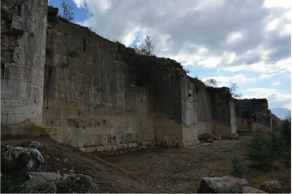
Fot. 15: Kapalı kısım batı cephesi.
