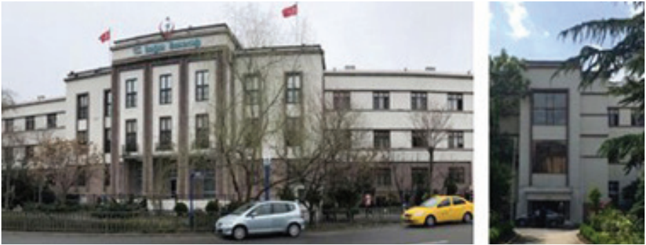
Fot. 5: Ana cephe ve arka girişten görünüm
