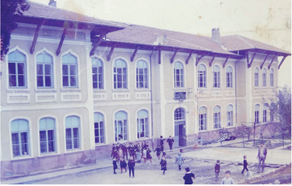
Fot. 17: Giriş Cephesi (Orhan Gazi İlkokulu Arşivi)
