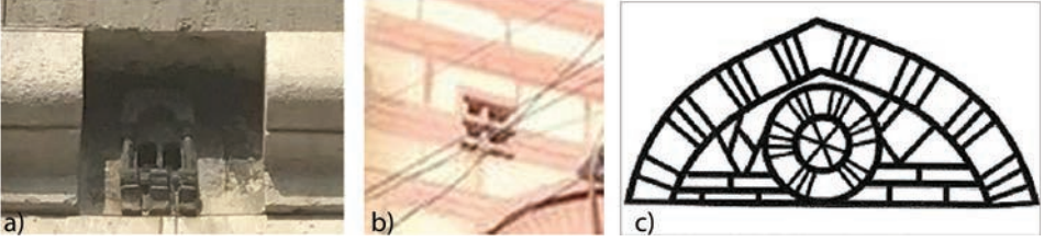
Görsel 13. Cephe süsleme öğelerinden. a) Taş kuş evi b) Tuğla kuş evi c) Güney cephede bir dönem yer alan pencere alınlığı. (Ersoy ve Uçar, 2013, 51.)
