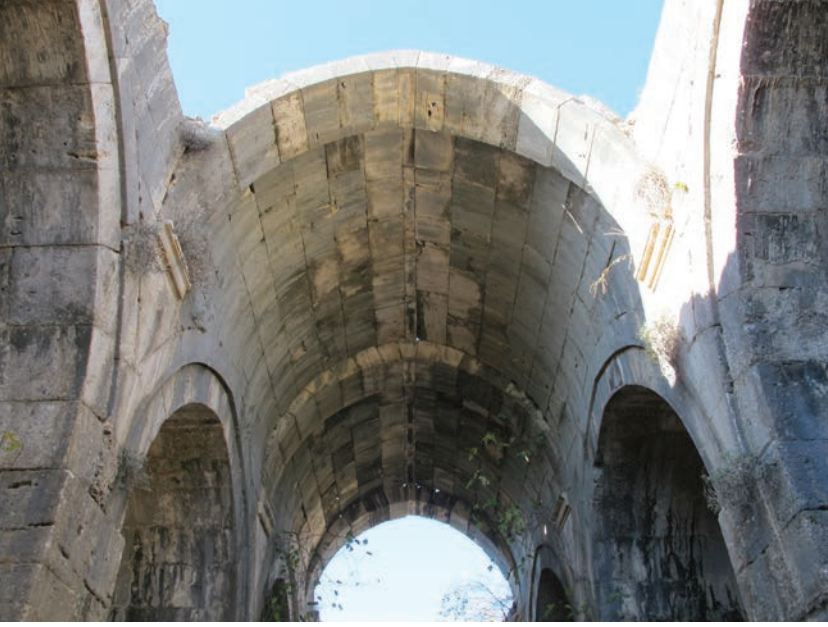
Fot. 20: Kapalı kısımda çapraz sahin tonozu.
