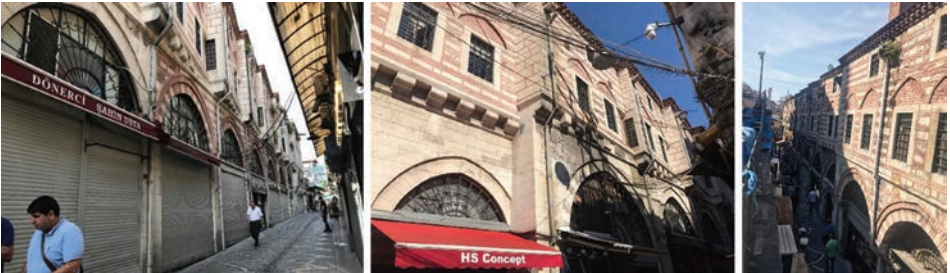
Görsel 14. Kılıççılar Sokağı üzerinde hanın güney cephesi.
