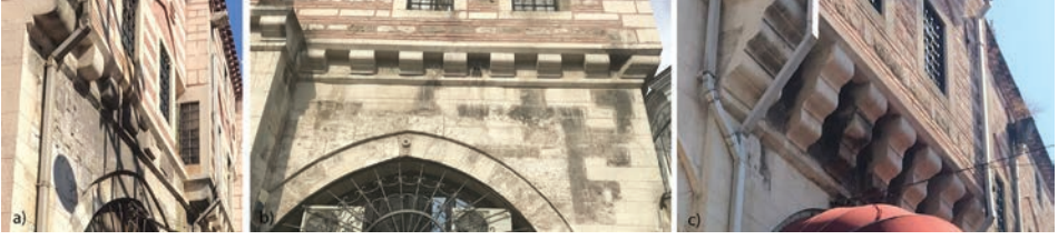
Görsel 25. a) Siyah tabaka oluşumunun tespit edildiği güney cephe (a), batı cephe (b, c).
