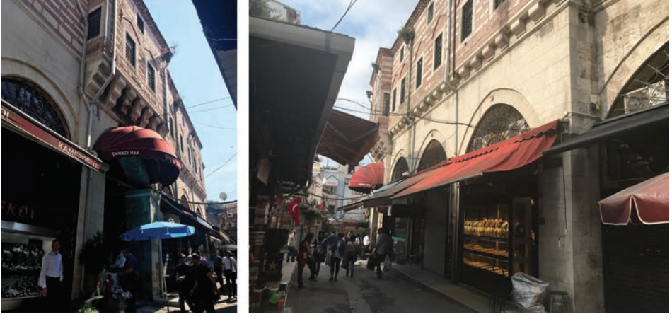
Görsel 12. Çuhacı Han Sokağı üzerinde hanın girişinin de yer aldığı batı cephesi.
