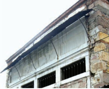
▲ ◀ Fot. 15 (a / b): Metal Saçak Altları
