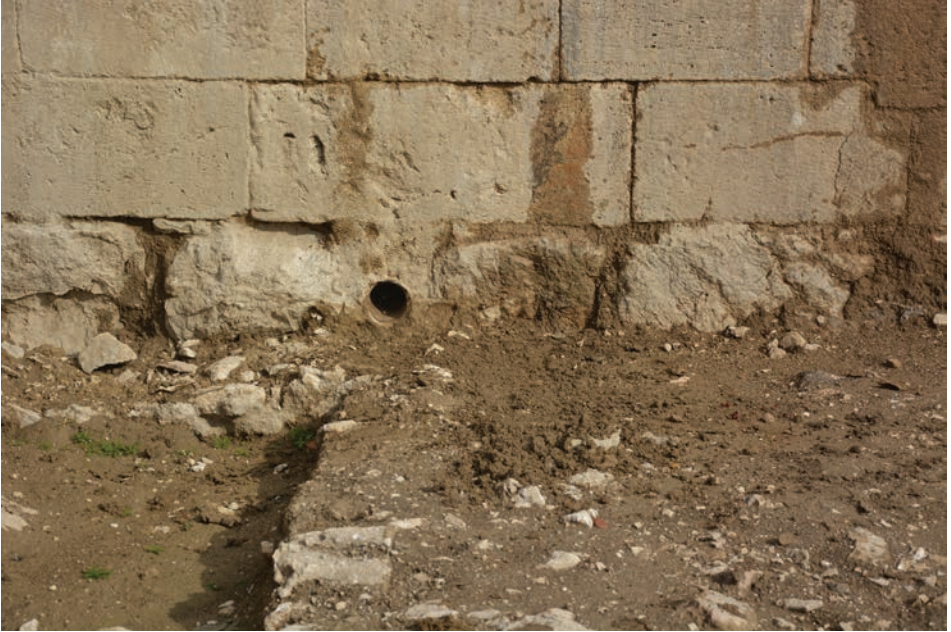
Fot. 9: Avlu doğu duvarında pişmiş toprak künk.
