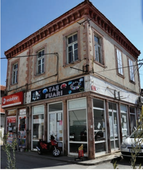
Fot. 5: İki Katlı Dükân Örneği
