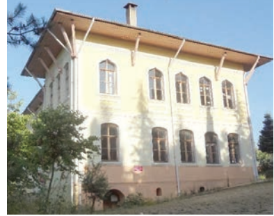
Fot. 12: Orhan Gazi İlkokulu Yan Cephesi (2018, N. Benli Yıldız)
