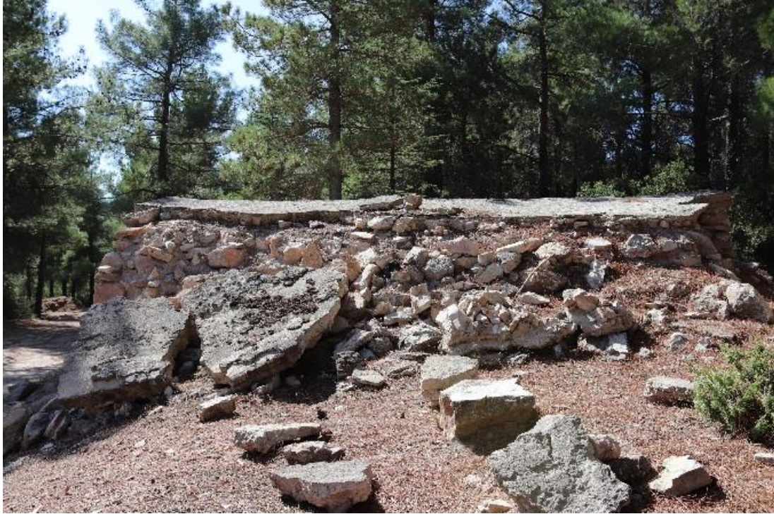
Fotoğraf 8: Doğu cephe duvarı
