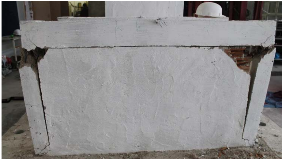
Şekil 7. Deney numunesinde oluşan hasar durumları [9] (Damages in the test specimen)
