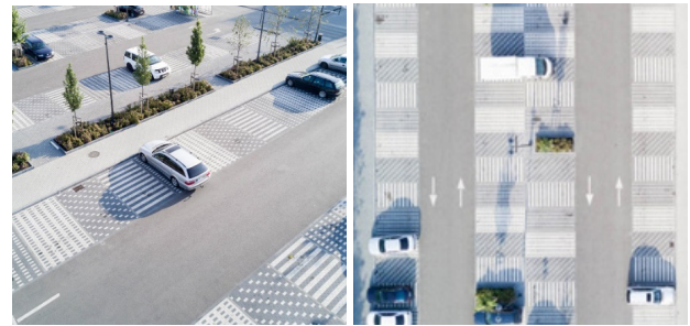
Görsel 6a ve 6b. Litvanya'da DO Mimarlık tarafından tasarlanan açık otopark yeri (Görsel kaynak: https://www.archdaily.com/921226/ogmios-city-public-space-do-architects Erişim Tarihi:26.04.20)
