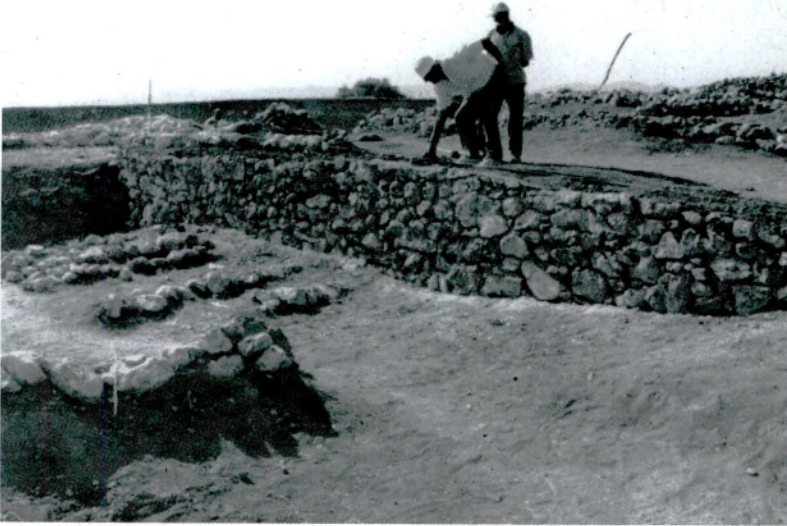
Levha 51/2- İTÇ II / 3 yapı katının 1 numaralı yapısının temelleri altına yapılan istinat/dayanak duvarı. Plate 51/2- Retaining/support walls constructed under the foundations of EBA II / 3 - House 1.
