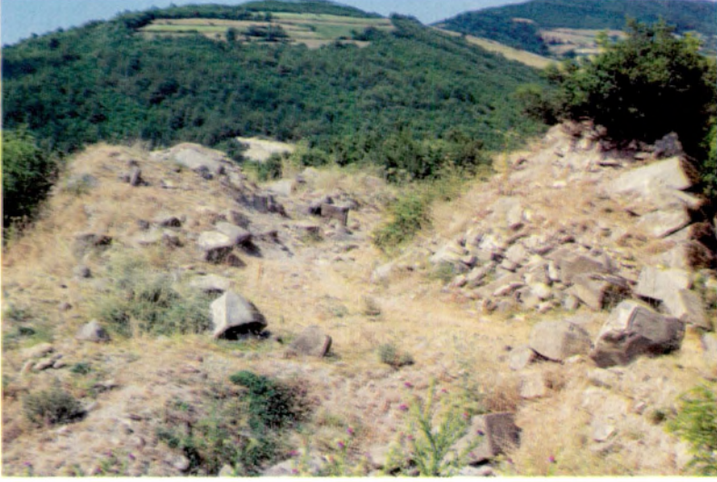
Res.15 - Kaçak kazılar sonucunda sur duvarında yapılmış tahribat, Akalan Kalesi
