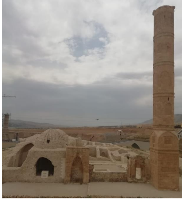
Resim 25: Yeni Hasankeyf Kültür Park'ta Şehabiye Medresesi 1.
