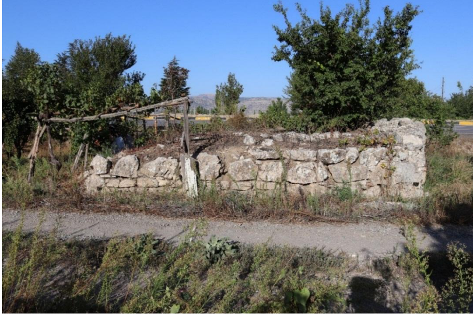
Fotoğraf 4: Çeşmenin güneydoğu yan cephesi
