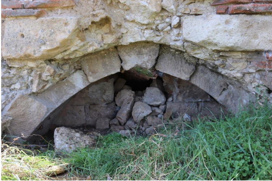
Fotoğraf 7: Havalandırma penceresi ve niş içerisindeki duvar örgüsü
