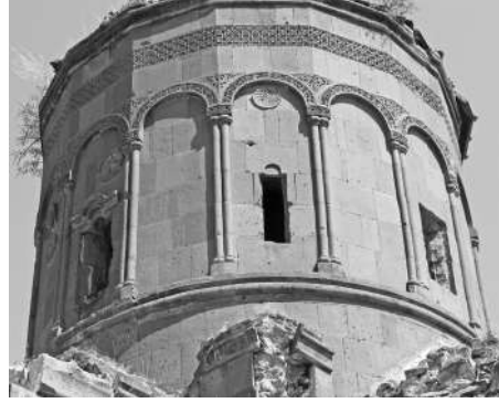
Resim 4: Kars / Ani, Şirli Kilise (Tigran Honents Kilisesi) konik külahlı çatı örtüsünden görünüm. Türk mimarisindeki kümbet görünüşünü hatırlatan konik çatının kasnak kısmında dışarıda Türk mimari eserlerinde çok kullanılan dışarıda birbirine bağlanan altıgenlerden oluşan şerit halindeki süsleme, kemer ve kemer aralarında bulunan Türk İslâm üslubunda süslemeler ve nihayet kemer alınlığında Türk İslâm tezyinatının vazgeçilmez öğelerinden olan çark-ı felek şekli görülmektedir. (Fotoğraf: Yaşar Çoruhlu, 2008).
