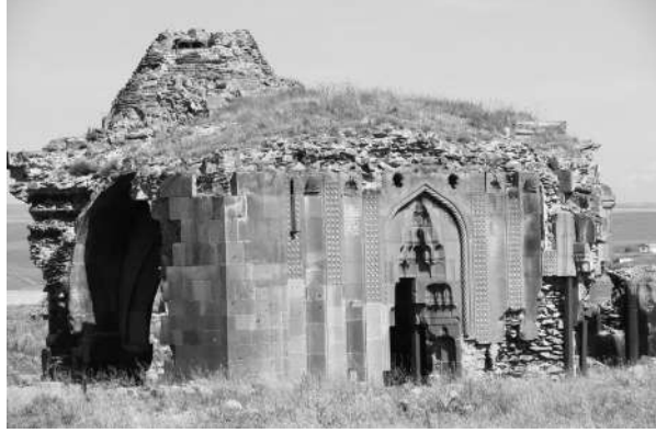
Resim 24: Kars / Ani'de Selçuklu devrinde kervansarayaya dönüştürülmüş (11. yüzyılın ilk yarısı) Havariler Kilisesi'nin doğu cephesinde, Selçuklu karakterini taşıyan taş işçiliği, içte kubbe kesiminde olduğu gibi özellikle mukarnas uygulaması ile dikkati çekiyor (Fotoğraf: Yaşar Çoruhlu, 2009).
