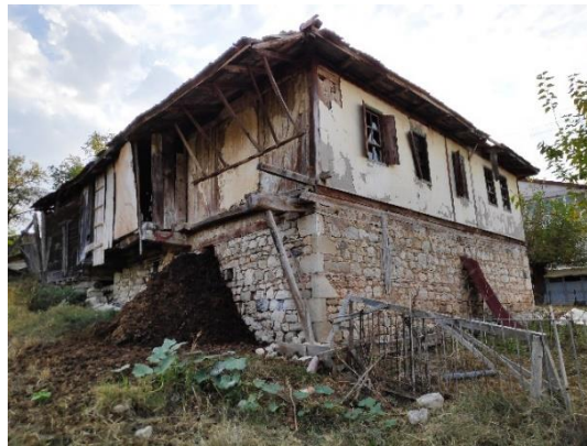
Şekil 13. Geniş çatı saçağının payandalarla desteklenmesi (Küçüksu köyü).
