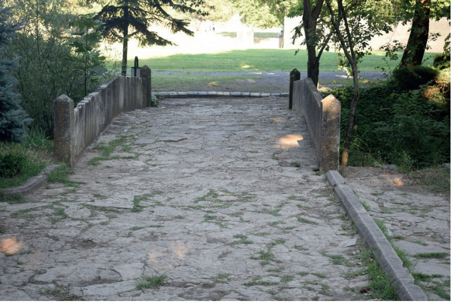
Res. 4: Hünkâr Köprüsü Tabliye
