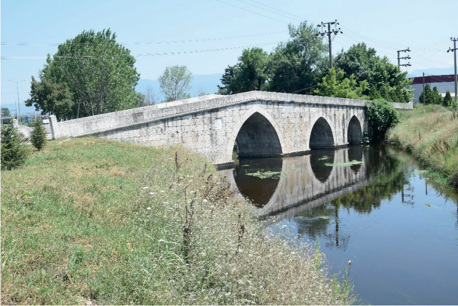
Res. 10: İzmit Kethüda Caferi Hatun (Kilezdere) Köprüsü Doğu Cephe
