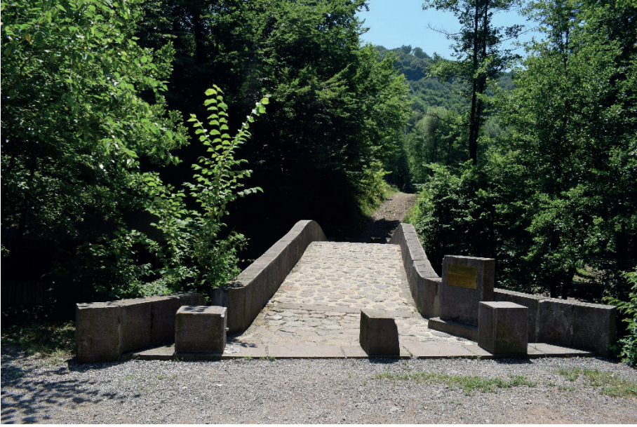
Res. 17: Başiskele Servetiye Köprüsü Tabliye
