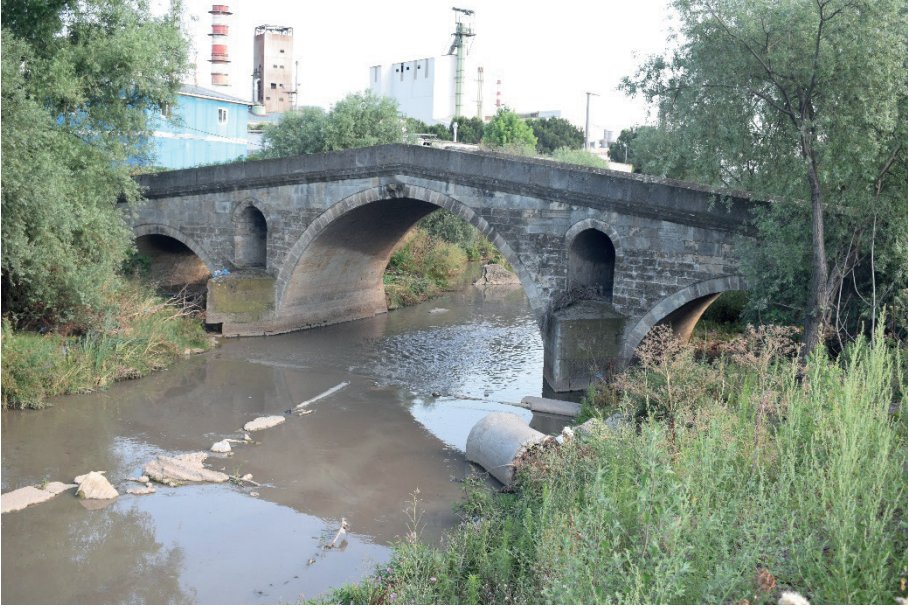
Res. 5: Gebze Kanuni Sultan Süleyman (Mimar Sinan) Köprüsü Kuzey Cephe
