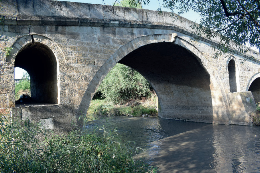
Res. 6: Gebze Kanuni Sultan Süleyman (Mimar Sinan) Köprüsü Güney Cephe
