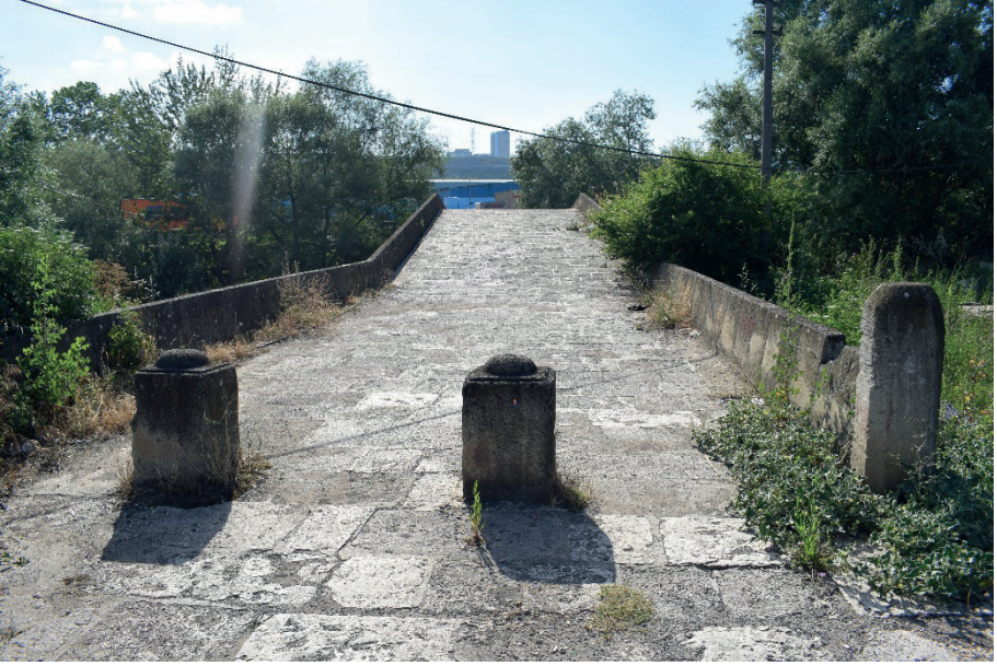
Res. 7: Gebze Kanuni Sultan Süleyman (Mimar Sinan) Köprüsü Tabliye
