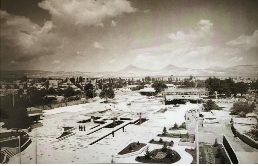
Şekil 6. Kültürpark'ın inşa çalışmaları 1969 (Konya Ticaret Odası, 2018)
