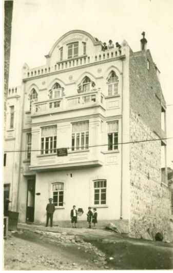
Şekil 10. Konya Sokak üzerinde yıkılmış bir apartman (VEKAM, t.y.)
