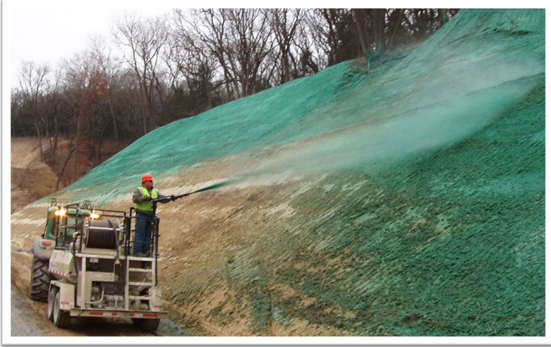
Şekil 1. Hydroseeding Uygulama Örneği (Url 1)
