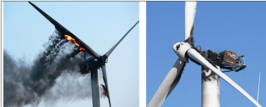
Şekil 3. Türbin Arızası ve Yangın [15, 16]
