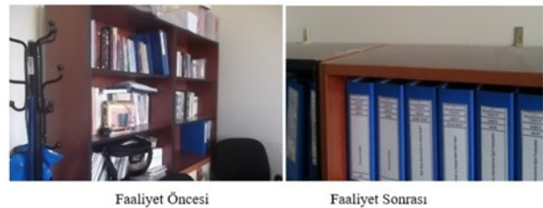
Şekil 3: Risk oluşturabilecek dolapların duvara sabitlenmesi.
