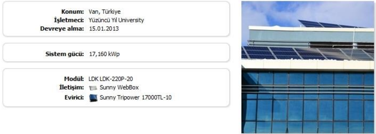
Şekil 1. Fotovoltaik sistemin genel tanımlanma bilgileri ve çatıda konumlandırılmış fotoğrafı.
