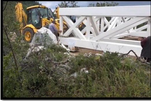
Fotoğraf 5. Çatak Kanyonu Cam Seyir Terası'nın çelik konstrüksiyonu 2017 ağustos ayında yerleştirilmiştir (URL 5).
