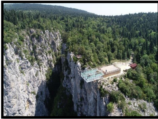
Fotoğraf 15. Çatak Kanyonu Cam Seyir Terasının boşlukta bulunan 15 m lik kısmının drone ile alınmış görüntüsü.
