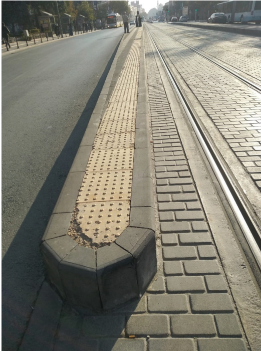
Fotoğraf 12: Mevlana Caddesi, tramvay yolu kaldırım düzenlemesi
