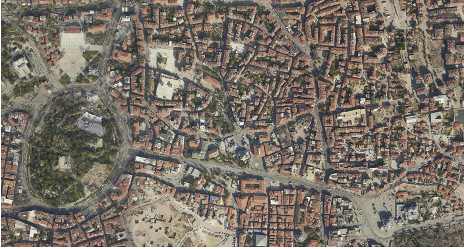
Fotoğraf 16: Konya Tarihi Kent Merkezi Uydu Görünümü (Konya Büyükşehir Belediyesi Kent Bilgi Sistemi)
