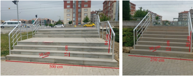
Şekil 12. Parselin batısında bulunan kaldırım seviyesinden geçişi sağlayan merdiven uygulamaları
