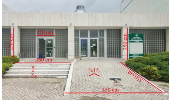
Şekil 19. C bloğa ait giriş düzenlemesi
