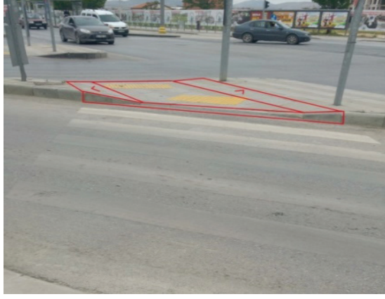
Şekil 5. Kışlaönü sokakta bulunan trafik ışıklarındaki kaldırım düzenlemeleri
