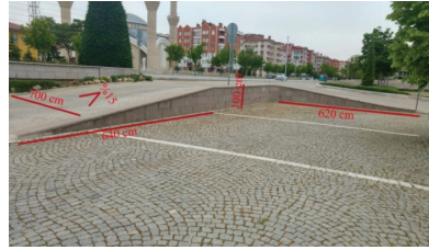
Şekil 10. Rampa eğimleri ve genişlikleri
