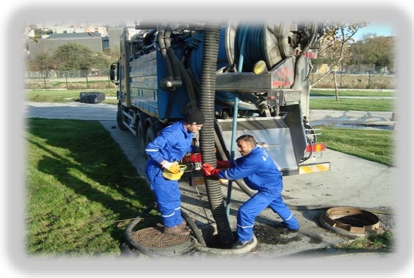
Şekil 1. Kombine ile kanal temizliği
