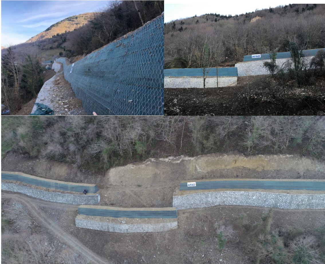
Şekil 14: Trabzon Maçka ilçesi güney mahallesinde taş duvar üzerine yapılmış toprakarme duvar imalatı
