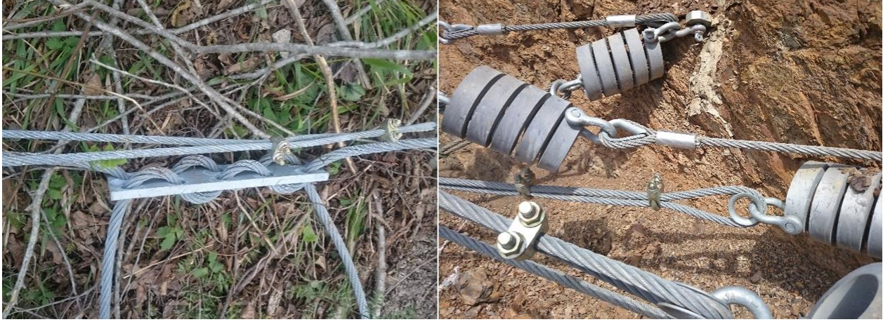
Şekil 13: Kaya çarpması sonrasında değişen enerji sönmüleyicilerin farklı türleri
