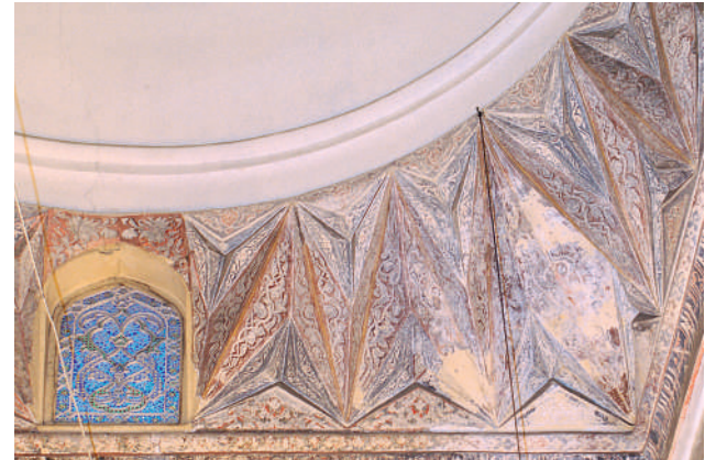
Görsel 8 Mihrap önü kubbe kasnağı 1783'te yenilenen nakışlar.
