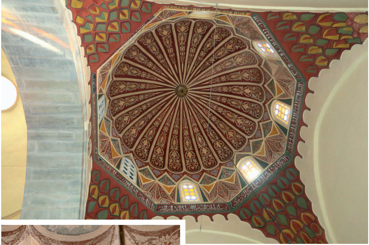
Görsel 13 Eyvan kubbesi 2010 onarım sonrası.
