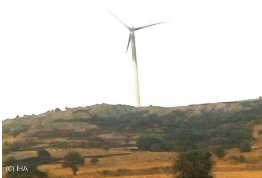
Şekil 7: Susurluk' da ki rüzgâr türbininde meydana gelen yangın.
