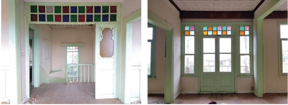
G. 16: Şekerpare Sokağı Köşkü Üst Kat Sofası (C. Balcan ve Z. S. Güneş Kaya Arşivleri, 2019).
