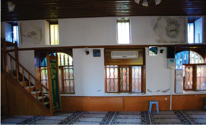
G. 2: Harim Batı Duvarı (A. Aydın, 2020)
