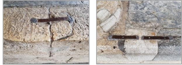
Şekil 1. Mevlâna Müzesinde bulunan yığma taş bloklar üstündeki kenet uygulamaları
