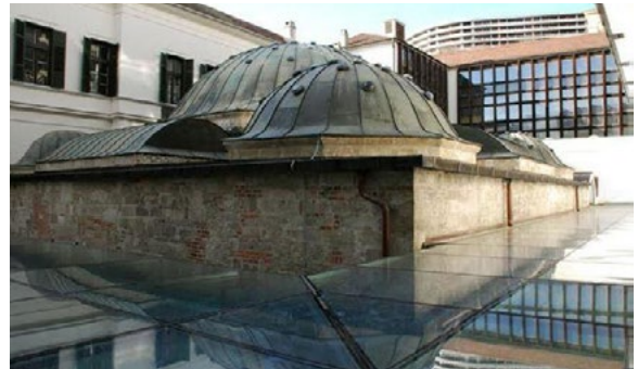
Resim 6. Veli Bey Hamamı Dış Görünüm
