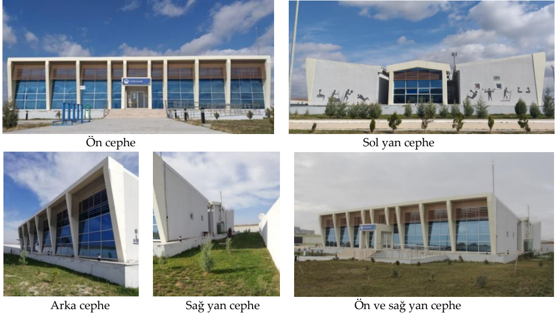
Şekil 9. Fitness Merkez Binasının cephe özellikleri, 2021
