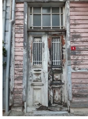
Şekil 6. Bostan sokak no:6 (B-1)
