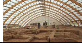
Çatalhöyük koruyucu kabuğu (Tayproject, t.y)
