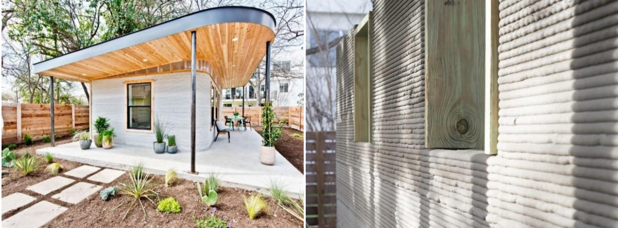
Şekil 10. Vulcan yapımı ev görseli ve duvar detayı (ICON Team, 2019) Figure 10. Home visual made of Vulcan and wall detail (ICON Team, 2019)
