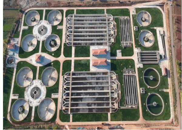
Şekil 1. Gaziantep merkez ileri biyolojik atık su arıtma tesisi
