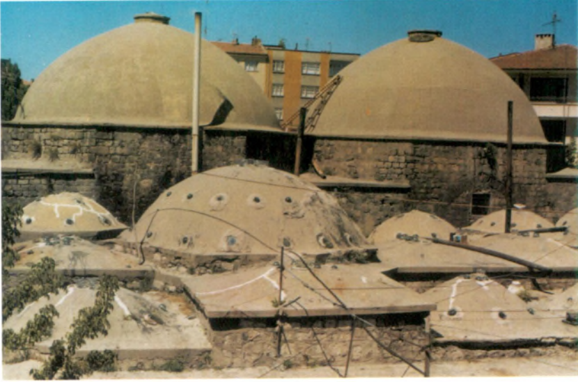
Resim 25 - Bor Sokullu Mehmet Paşa Hamamı, örtü sistemi.
