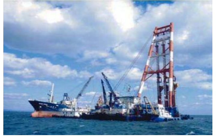
Şekil 14. Kum Kompaksiyon Kazıklarının Denizde Yerleştirilmesi. (Kitazume, 2007)
