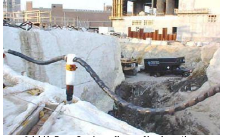
Şekil 11. Zemin Dondurma Yöntemi Uygulama Alanı. (foam-tech,2008)
