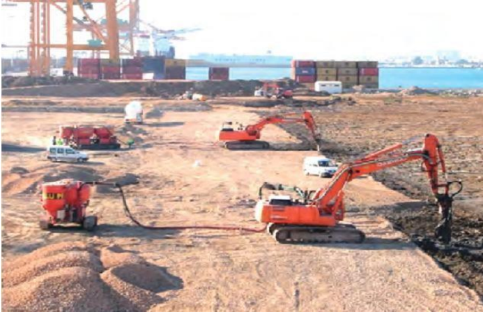
Şekil 23. Çimento ile Karıştırma Yönteminin Kullanıldığı Alan. (Burgos ve diğ., 2007)
