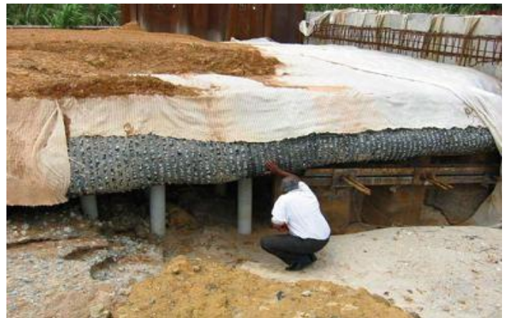
Şekil 19. Erozyona uğramış dolgu. (Huesker,2008)
