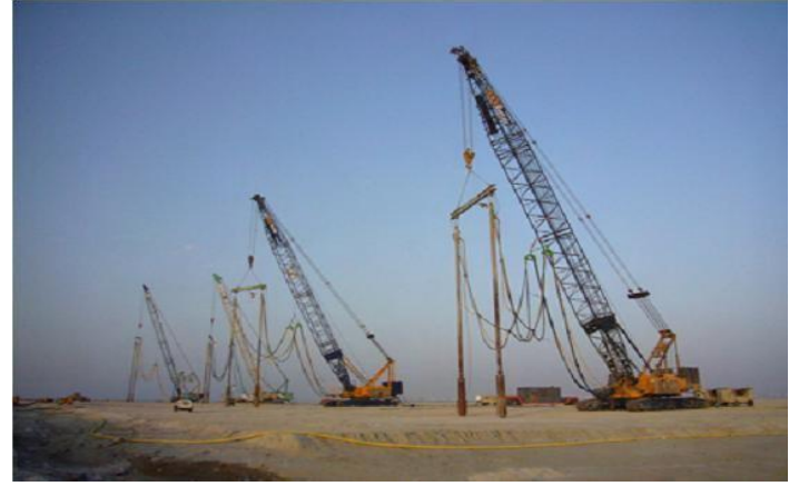
Şekil 2. Dubai Palm projesinde kullanılan titreşimli sondalar. (Wehr, 2007)
