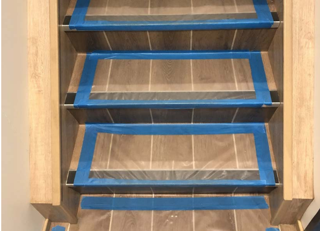
Şekil 19: Basamak profili uygulanmış merdiven (Fotoğraf: Yazar).
