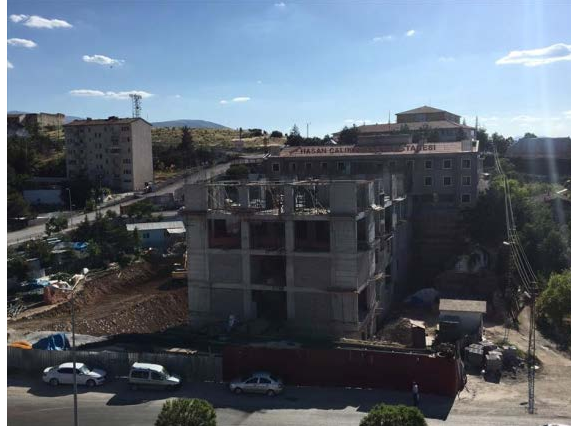
Şekil 6: Malatya Yeşilyurt Hasan Çalık 45 Yataklı Devlet Hastanesi mevcut bina tadilat ve ek bina inşaatına yönelik bir görsel
