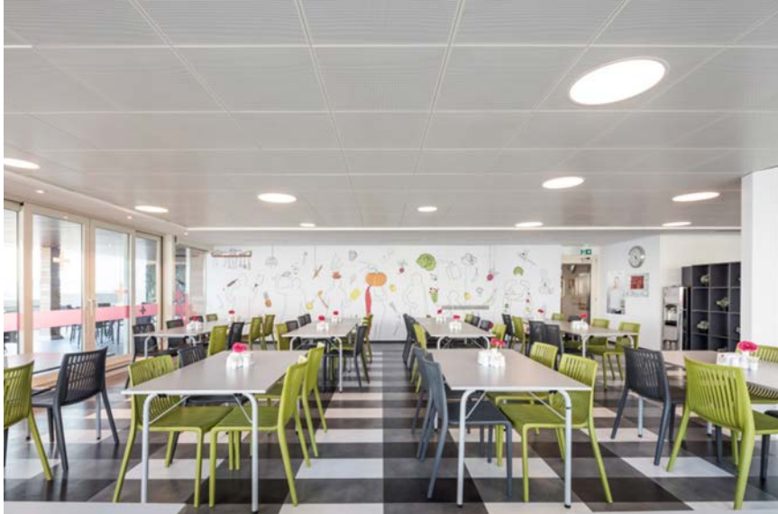
Fot. 3: Gizli Taşıyıcılı Geçmeli Asma Tavan Sistem Örnek Fotoğrafı (URL 1)
