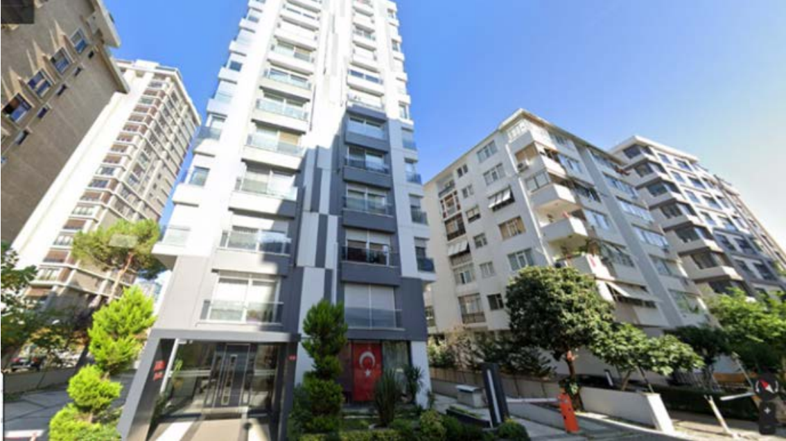
Şekil 24: Şekil 23'teki Konutun/Apartmanın Kapatılan Zemin Katının Görünümü
