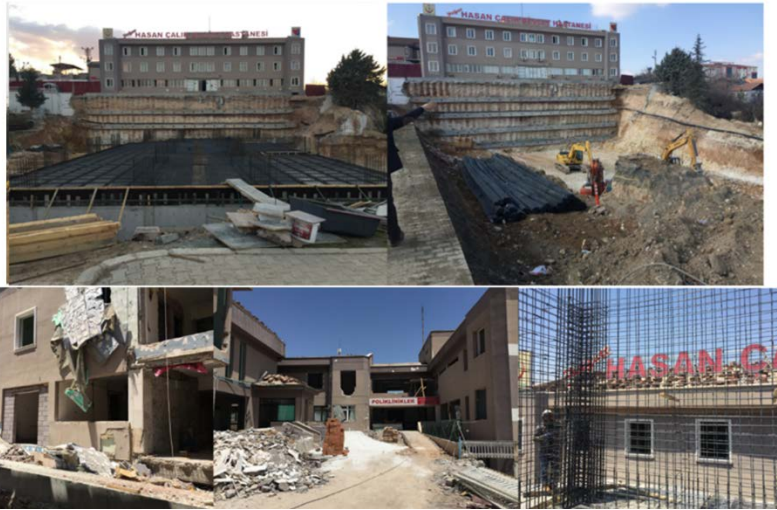
Şekil 7: Mevcut yapı cephesine müdahale süreçleri (Nurettin Aykutlu arşivinden; 2018)
