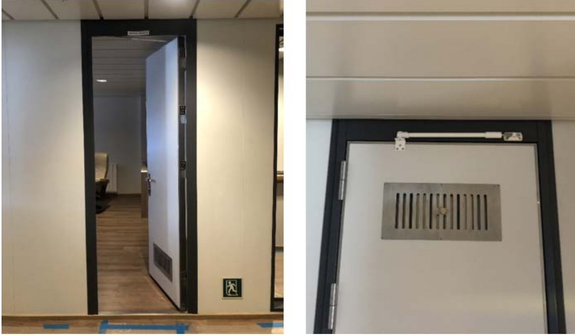
Şekil 14: B-15 sınıfı kamara kapısı (Fotoğraflar: Yazar).
