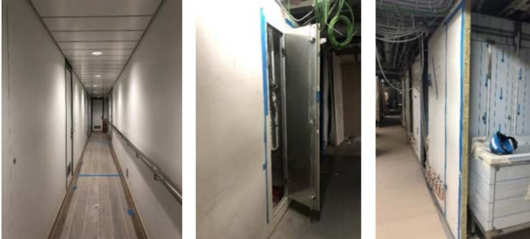
Şekil 5: Solda koridorda bulunan kuru alan duvar panelleri; ortada, koridorda bulunan müdahale kapaklı duvar paneli tipi; sağda, soyunma odasında bulunan ıslak alan duvar panelleri (Fotoğraflar: Yazar).
