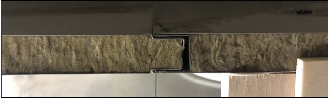
Şekil 9: Birbirine geçme detayı ile bağlanan duvar paneli örneği (Fotoğraf: Yazar).
