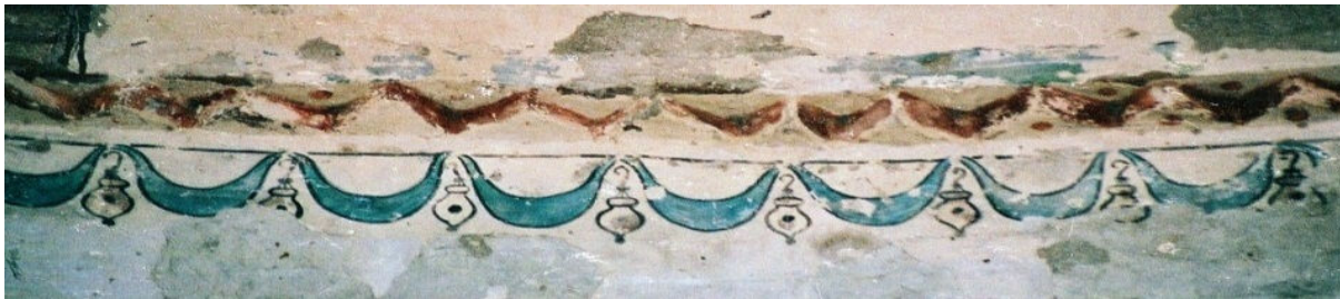
Hüsrev Paşa Camii Kandil Süsleme Onarım Öncesi Görünüşü
