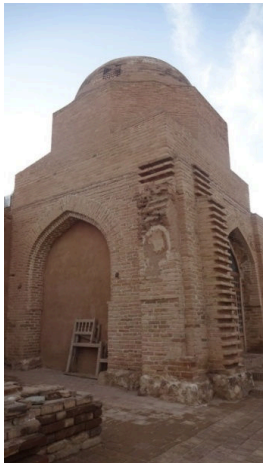
Gurve Camii, Doğu Cephe
