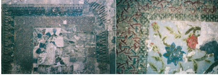
Hüsrev Paşa Camii Mihrap Onarım Öncesi Kalem İşi Süsleme Görünüşleri
